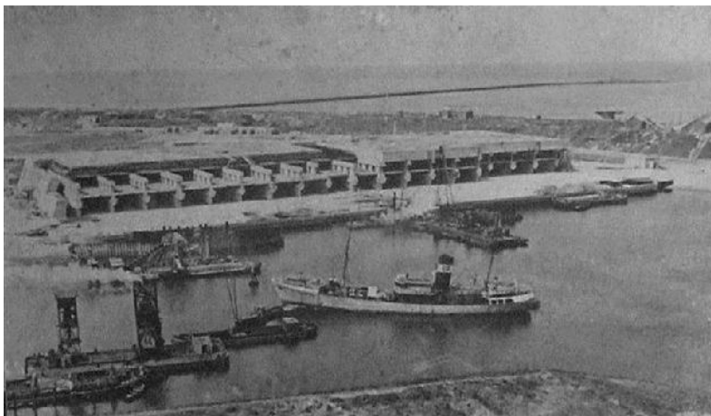
Schnellboot bunkers in IJmuiden tijdens de bouw.
